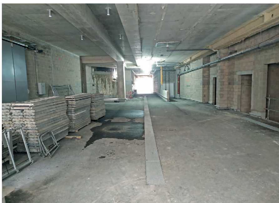
La galerie de livraison en travaux, vue depuis l'entrée Vercingétorix
