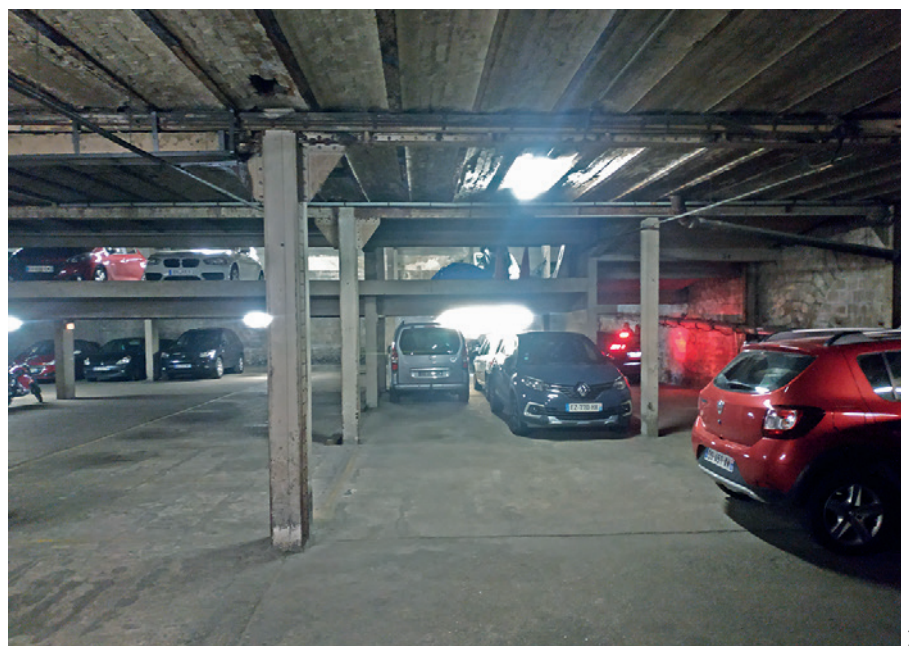
Le sous-sol actuel, à transformer en ELU
