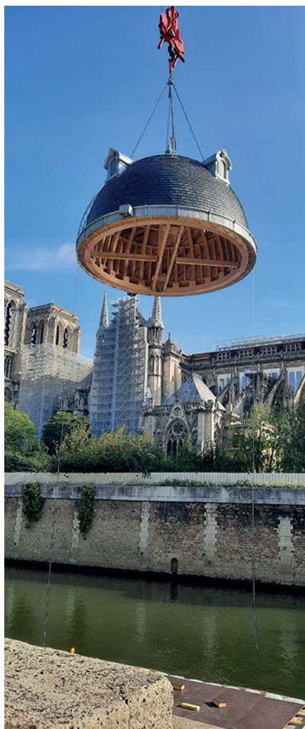
L'acheminement de deux dômes de 6 tonnes chacun et de plus de 6 m de diamètres, depuis le port de Charenton jusqu'à l'île de la Cité (1 er )
