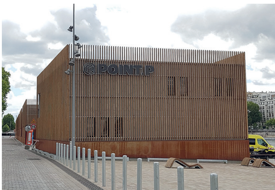
Port de Javel – bâtiment de Point. P. (15 e )
