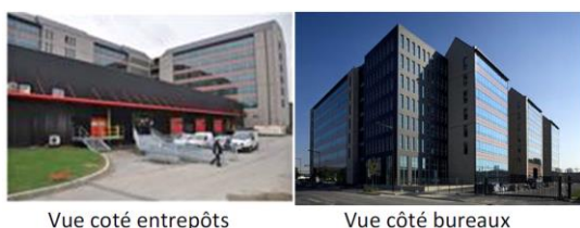
ILLUSTRATION 14 : Bâtiment 521 du Parc des Portes de Paris
