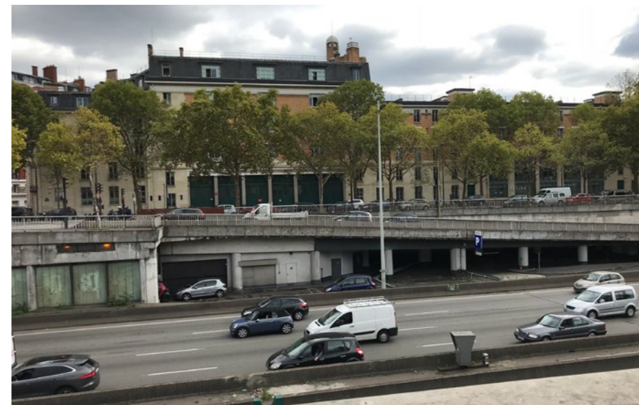
Figure 8 – Ancienne station-service de la porte de Champerret faisant l'objet d'un projet de reconversion en site logistique (Paris 17 e ). ©Sogaris
