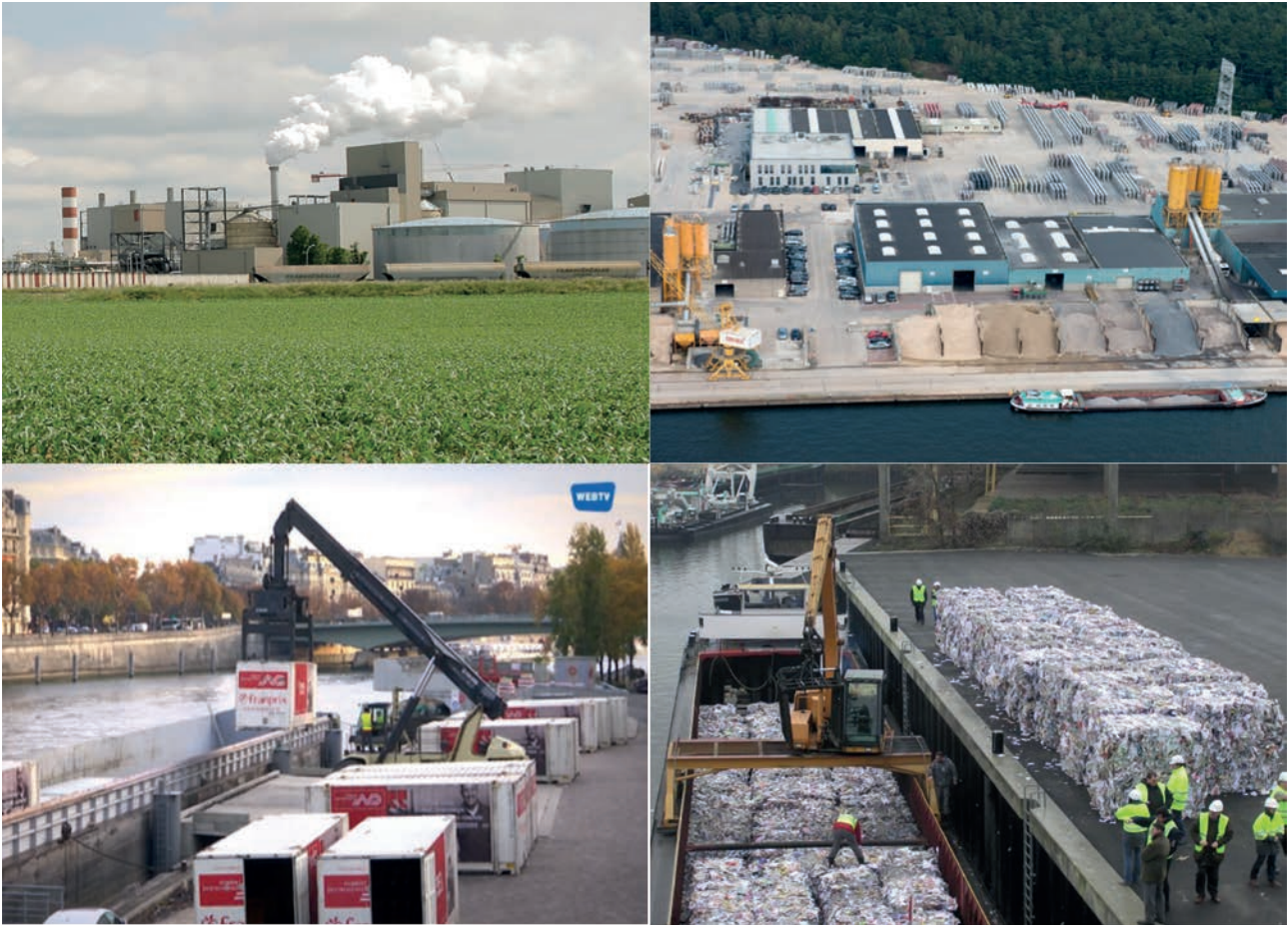
Figures – en haut à gauche : Usine agro-industrielle de Nestlé – Photo©Tereos ; en haut à droite : Usine de préfabrication sur le Canal Albert (Flandre) – Photo©devlaamsewaterweg ; en bas à gauche : Quai de la Bourdonnais, chargement de conteneurs – Photo©portsde-paris ; en bas à droite : Chargement de produits recyclables (Paris) – Photo©vnf.
