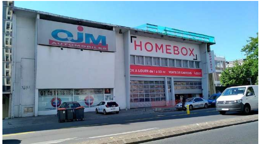
ILLUSTRATION 21 : PHOTO DE LA FAÇADE DE L'ENTREPÔT HOMEBOX SUR LA RD 932
