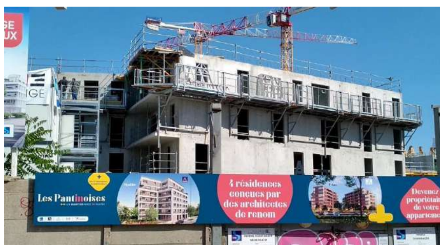
ILLUSTRATION 13 : PHOTO DU QUARTIER EN CONSTRUCTION LES PANTINOISES
