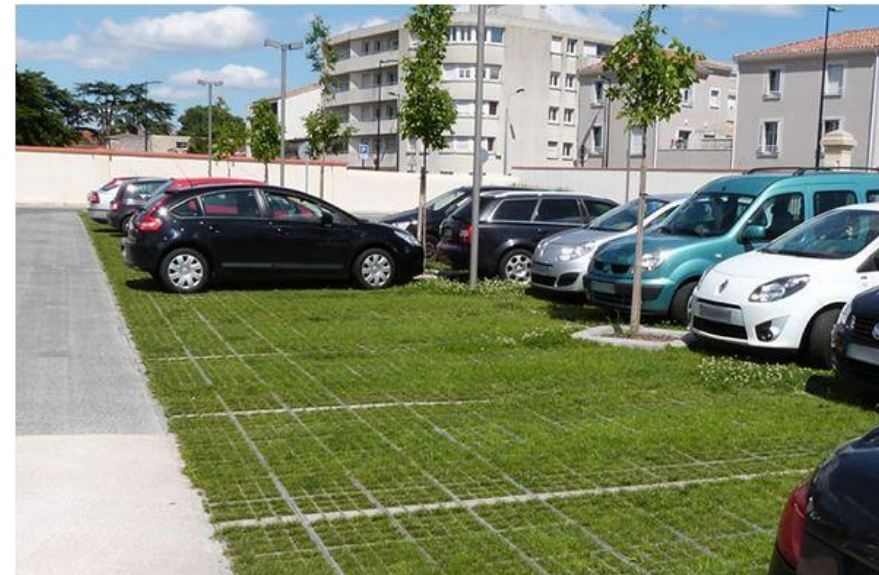
Parking en revêtement « végétalisé » (Lyon)
