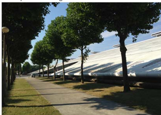
Allée piétonne longeant l'Esiee
