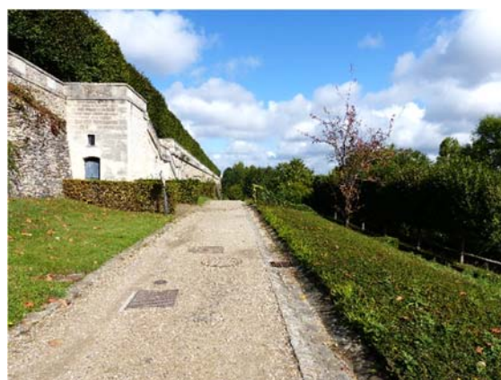
Cheminements en bas des contreforts
