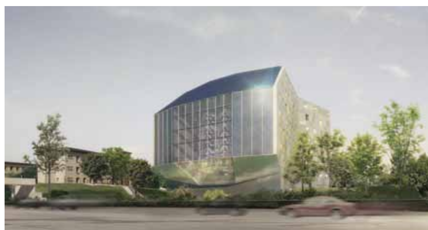
Maison de l'Île-de-France – CIUP / Paris (75) Panneaux solaires thermiques et photovoltaïques sur la façade sud Architecte : Atelier Nicolas Michelin et Associés + DEERNS Crédits photo : Atelier Nicolas Michelin et Associés
