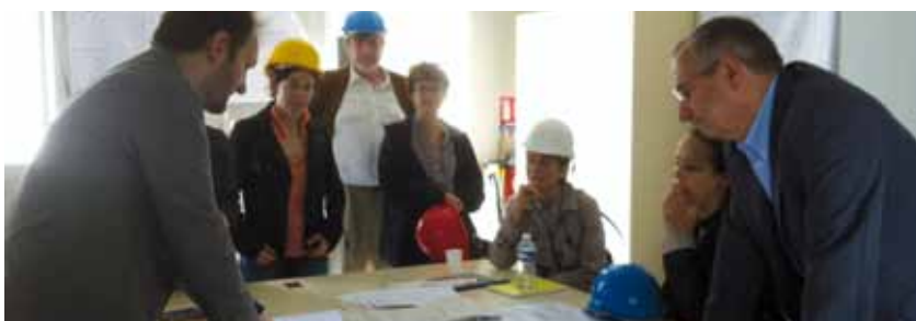
Maison des étudiants de l'Université Paris-Est / Champs-sur-Marne (77) Réunion de chantier Architecte : Adrien HENOCQ / Crédits photo : Région Île-de-France
