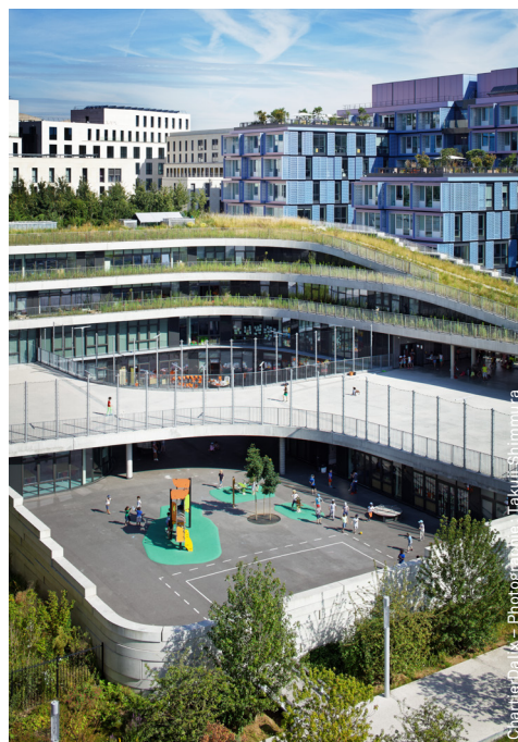
École des sciences et de la biodiversité et son gymnase - Boulogne-Billancourt : avec 345 espèces végétales ou animales recensées, la biodiversité du bâtiment est comparable à celle d'un parc urbain.
