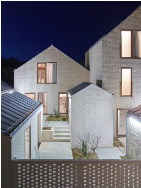
Une opération mêlant espaces bâtis et non bâtis, communs et individuels
