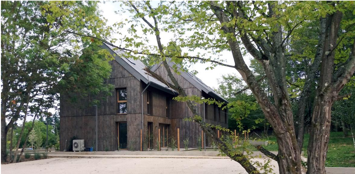
Des logements en ossature et bardage bois et des espaces extérieurs communs généreux
