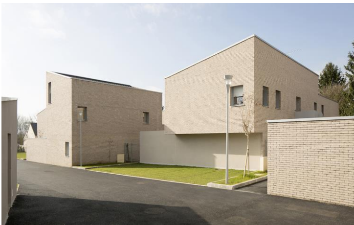
Utilisation de la brique claire à joint creux comme matériau de façade
