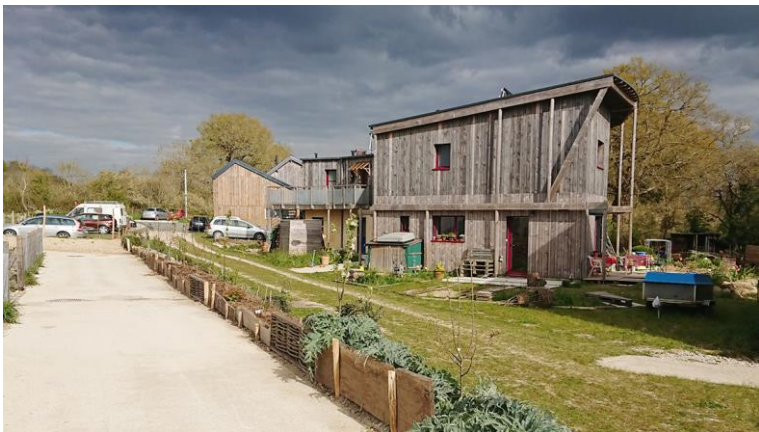
Des espaces partagés ont été auto-construits par les habitants : atelier, salle commune, buanderie...
