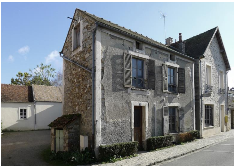
État de la maison de bourg avant réhabilitation
