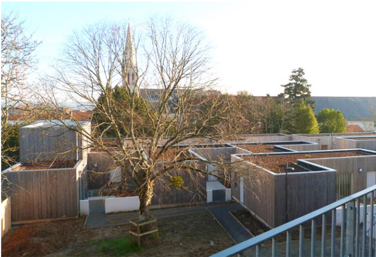
Vue sur les maisons ossatures bois
