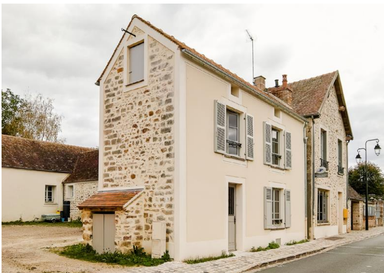
Maison réhabilitée pour en faire un logement en duplex. Amélioration des performances thermiques du bâti
