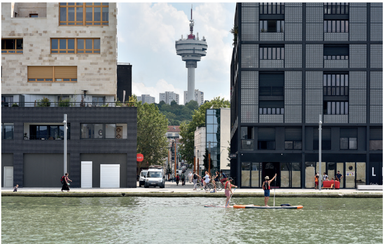
Secteur Raymond Queneau, Ville de Pantin, Canal de l'Ourcq. Vue des opérations d'aménagement livrées en 2018
