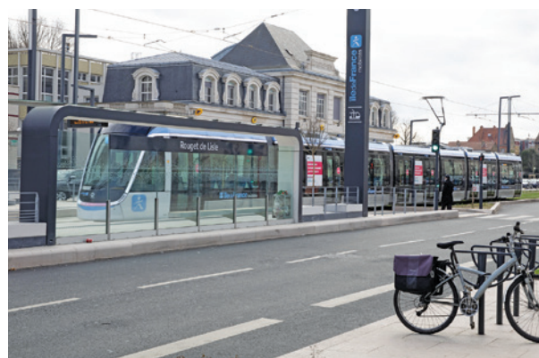
Station du tramway T9 Rouget-de-Lisle à Choisy-le-Roi, mise en service en avril 2021
