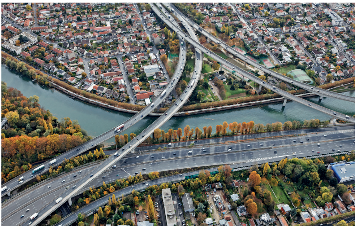
Maisons-Alfort - Saint-Maurice : l'autoroute A4, la Marne et l'échangeur avec l'autoroute A86
