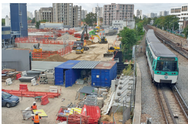
Gare de Créteil l'Échat en travaux en août 2020, Grand Paris Express ligne 15 Sud
