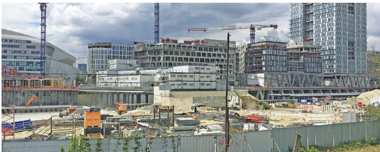
Gare de Nanterre La Folie en travaux en juillet 2020, Grand Paris Express ligne 15 Ouest
