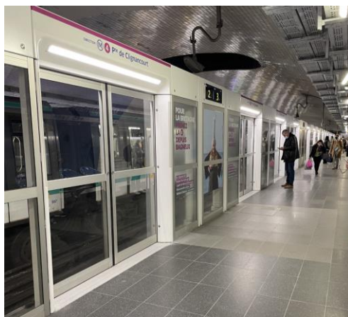
Façades anti-suicides sur le quai du métro 4 à Paris-Montparnasse © A. Vielcanet
