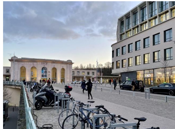
Parvis et bâtiment voyageur historique de Versailles Chantiers après rénovation (2021) © A. Vielcanet
