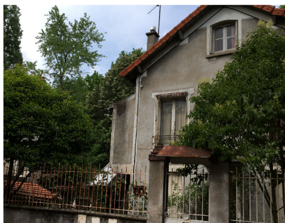
Pavillon abandonné, boulevard Camélinat à Malakoff
