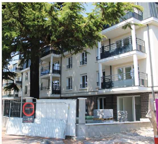
Construction d'un immeuble collectif à la place de pavillons à Tremblay-en-France
