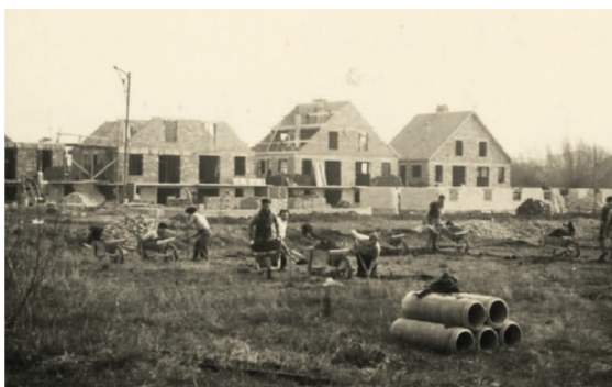
Cité Castors en construction à Antony
