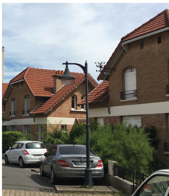
Ensemble de maisons HBM à Maisons-Alfort
