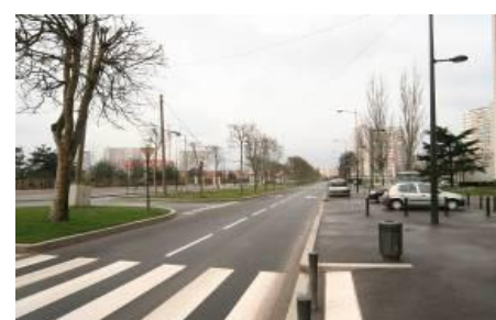
Avant requalification de l'existant.
