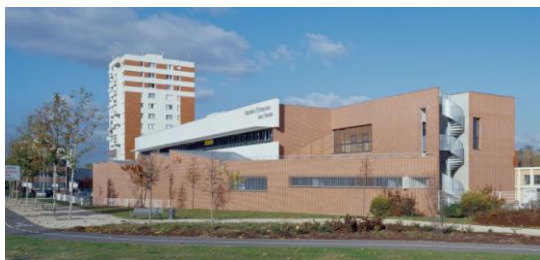
Ville des Mureaux Pépinière Isaac Newton
