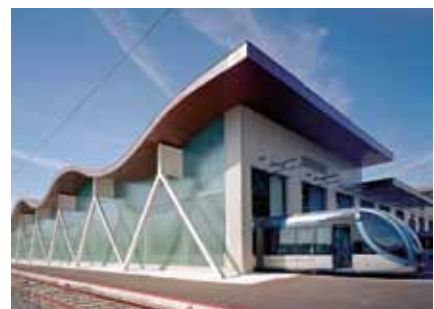
Le dépôt-atelier du tram de Bordeaux.
