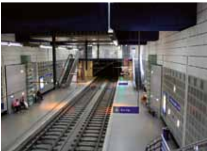
Une des stations souterraines du réseau de Rouen.
