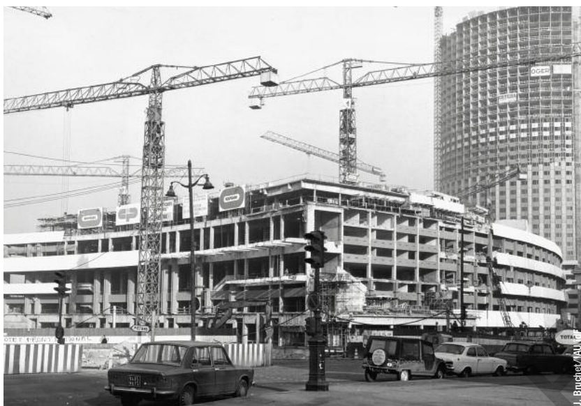
Chantier de construction du Palais des Congrès, Porte Maillot à Paris.
