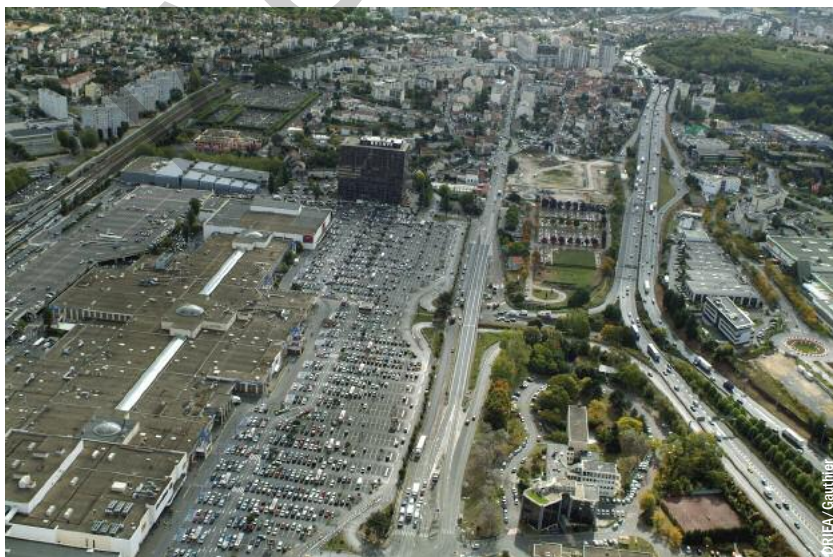
Un mètre carré de commerce s'accompagne, en moyenne, d'un mètre carré de stationnement. Ici, le centre commercial Rosny 2.
