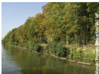
Stabilisation de berges et renaturation par génie écologique à Neuville-sur-Oise (95).
