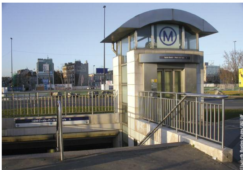
Station Saint-Denis-Porte de Paris, sur la ligne 13 du métro.
