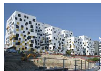
Chantier de recyclage urbain à Nanterre (92).
