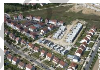
Lotissement en extension à Saint-Germain-lès-Corbeil (91).
