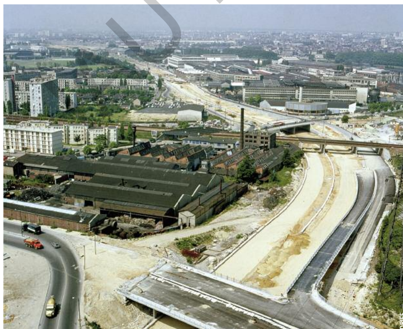
Construction de l'autoroute A86 à Gennevilliers (92).
