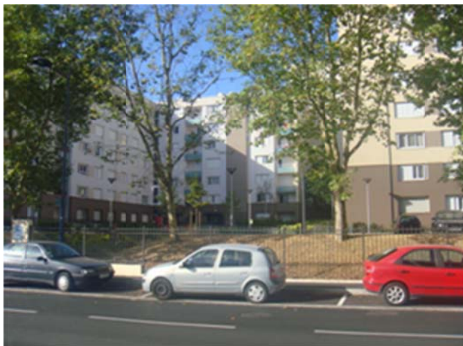
Bâtiment réhabilité et résidentialisé
