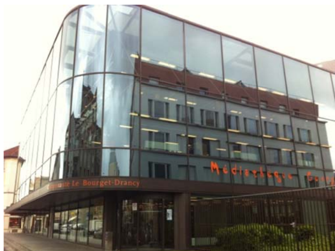
La médiathèque Georges Brassens de la CA de l'Aéroport du Bourget
