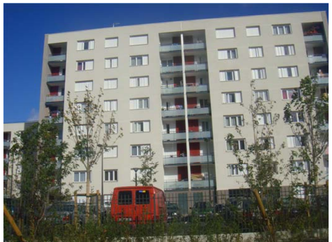
Bâtiment réhabilité et résidentialisé
