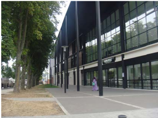
Bâtiment en cours de réhabilitation
