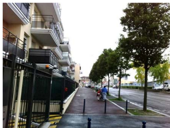
Avenue Marceau, immeuble neuf
