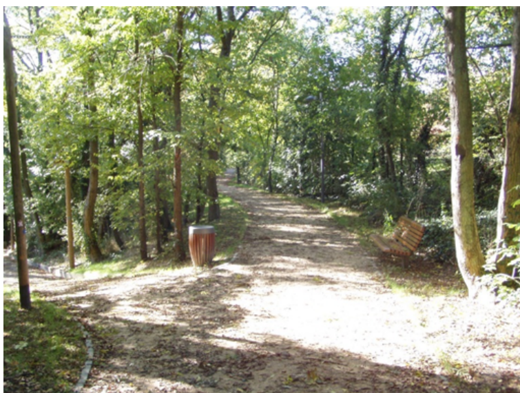
Piste cyclable et chemin piétonnier en Enverr'paq (revêtement à base de déchets de verre recyclés, à l'aspect sablé, proche d'un stabilisé) en site boisé sur le plateau de Saclay
