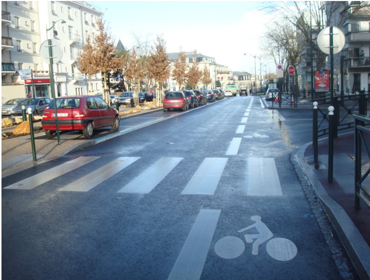
Exemple d'aménagement récent sous maîtrise d'ouvrage départementale : bande cyclable réalisée en 2013 le long de la RD75 au Plessis-Robinson
