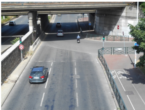
Pont de Rouen à Nanterre (92)
