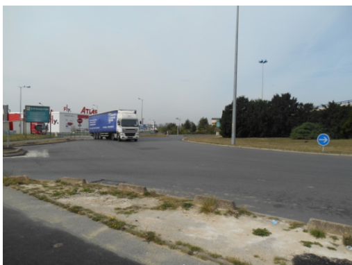
Carrefour Pompadour à Créteil (94)
