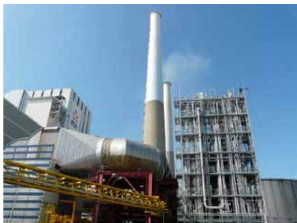
Pilote de captage de CO 2 d'EDF au Havre
