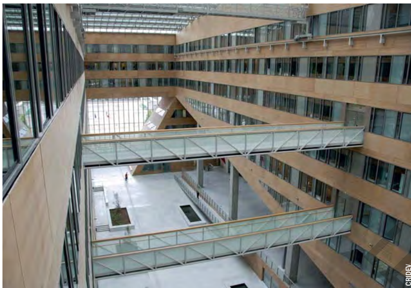
L'hôtel de région Rhône-Alpes, réalisé avec la démarche HQU a reçu le trophée Accessibilité 2013.
