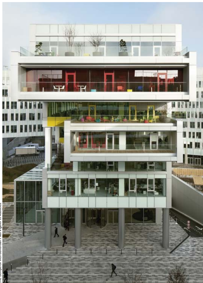
Le nouveau siège de SFR à Saint-Denis : un campus de 130 000 m 2 pouvant accueillir 8 500 salariés.
