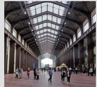
La nef centrale et l'ossature Eiffel de style Art Déco
