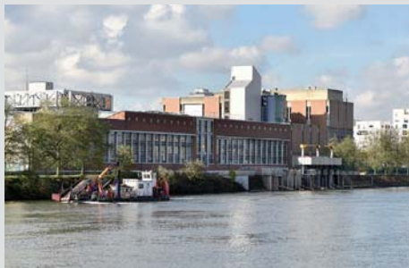
Usine des eaux de Choisy-le-Roi
