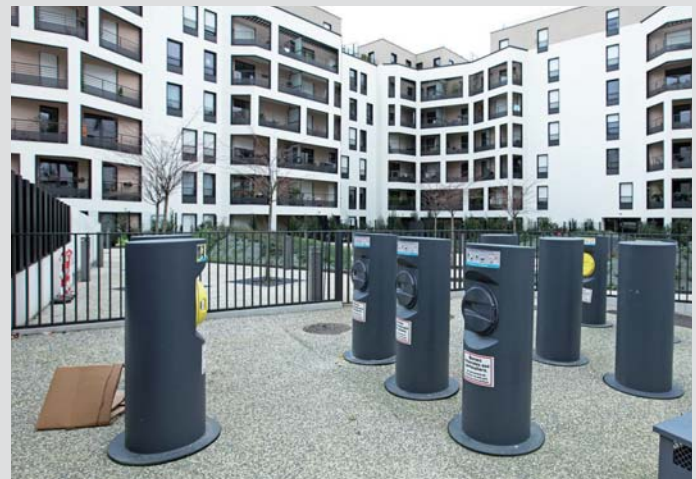
Collecte pneumatique des déchets à Issy-les-Moulineaux
