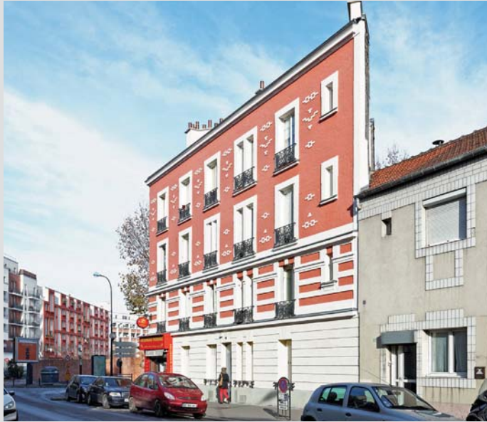
24, rue Suger - Saint-Denis. Dans le cadre du programme de lutte contre l'insalubrité, cet immeuble, sous l'impulsion de l'Opah, a fait l'objet d'une réhabilitation globale.
