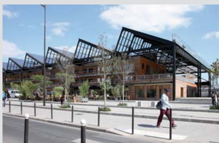
La halle Pajol rénovée
