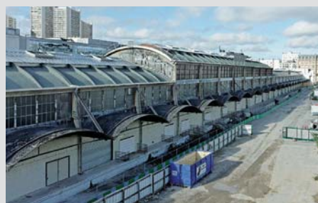
État actuel de la halle Freyssinet
