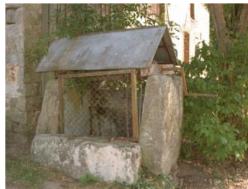
Puits dont la structure, notamment les jambages latéraux sont très particuliers, à peine maçonné (Heurtevent commune de Chevry-en-Sereine,
