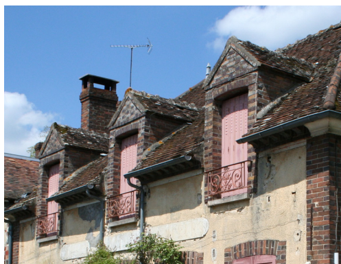
Lucarnes engagées avec entourage brique, Chevry-sous-le-Bignon
