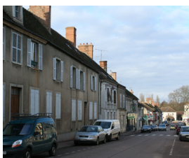
Linéaire urbain à Voulx, présentant des façades de maisons de bourg R+I, conférant une certaine homogénéité à la rue.
