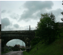
Viaduc de la Vanne à l'entrée de Pont-sur-Yonne
