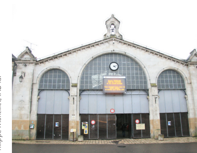
Marché couvert de Courtenay, construit au XIX e siècle
