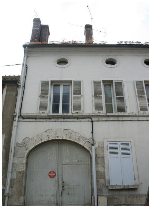
Porte cochère à arc cintré, volets semi-persiennés en rez-de-chaussée, persiennés à l'étage et jours de comble ronds à Egreville
