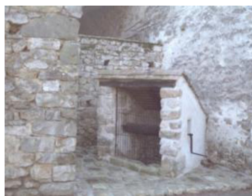
Puits sans margelle à Darvault
