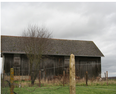
Hangar en bois à Bussy-le-Repos
