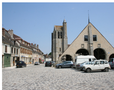
Façade sud de la halle d'Egreville, pignon de pierres
