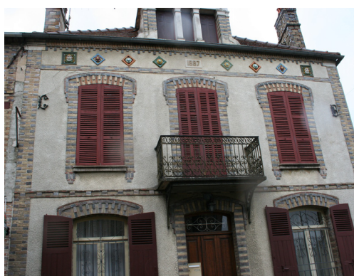
Intéressante maison de bourg, avec date portée (1887) à Pont-sur-Yonne. Motifs de céramiques sur la façade, belle forme travaillée des entourages de fenêtres, briques de différentes couleurs, balcons...
