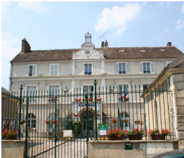
Hôtel de ville d'Egreville : en retrait par rapport à la rue et précédé d'une cour; l'hôtel de ville prend un aspect monumental grâce à ses doubles escaliers menant à l'entrée principale. La symétrie, le clocheton et le médaillon reflètent le pouvoir municipal
