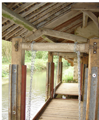
Lavoir à plancher mobile à Griselles
