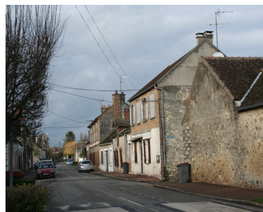
Façades R+0 et R+1 à Thoury-Férottes
