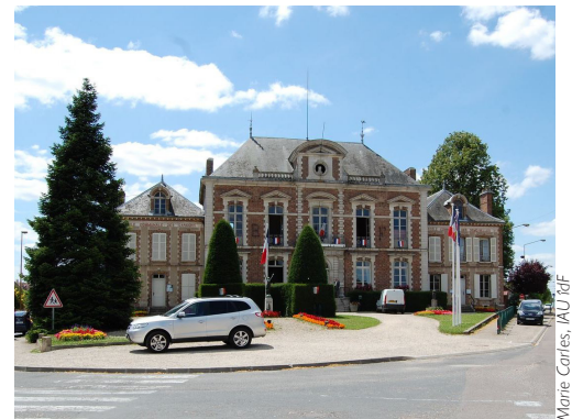
Mairie-école de Chéroy, construite après 1884 : de part et d'autre du bâtiment central de la Mairie, deux écoles symétriques aux entrées séparées, le tout dans un style monumental
