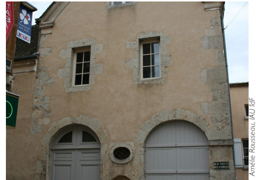
A Ferrières-en-Gâtinais, pignon d'une maison antérieure au XVII e siècle
