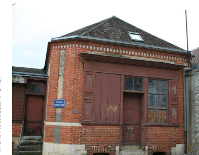
Un ancien commerce (échoppe) à Griselles. En plus de son intérêt du point de vue de l'activité ancienne qu'il représente, sont à noter les murs en brique et la frise ainsi que la devanture en bois, typique du XIX e siècle
