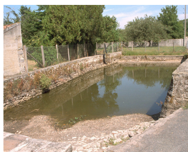
Abreuvoir à pente pavée à Chevry-en-Sereine dont 3 côtés sont maçonnés
