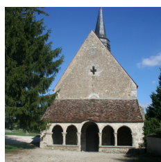
Cette humble église rurale de Rozoy-le-Viel est rehaussée par la présence de son « caquetoire » reposant sur de fines colonnettes
