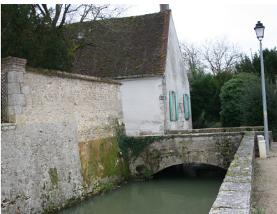
Pont à arche surbaissée à Ferrières-en-Gâtinais, sur un bras détourné de la Cléry Mail planté à Pont-sur-Yonne
