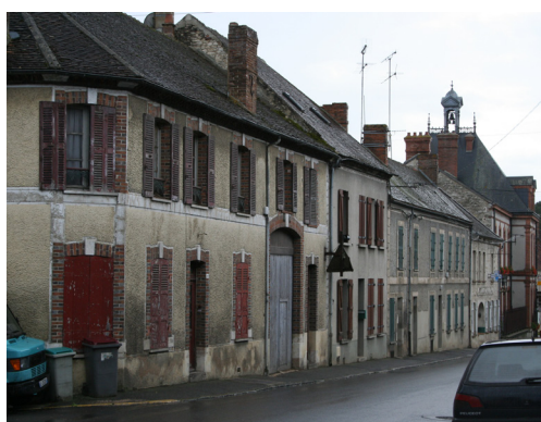
Maison de bourg à porte cochère à Lorrez-le-Bocage
