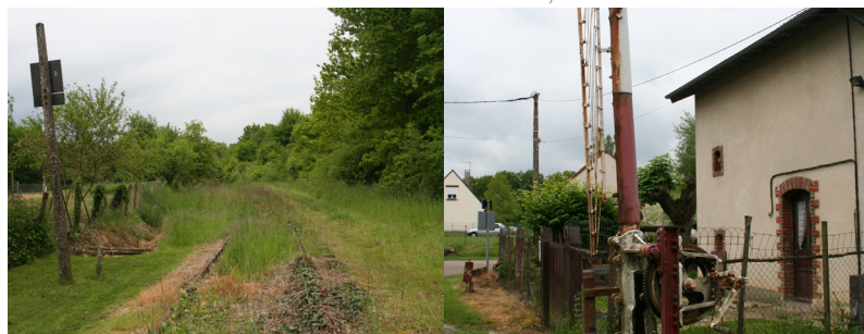
Vestiges de l'ancienne voie ferrée à Egriselles-le-Bocage
