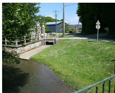
Au lieu-dit « les Rondiers » à Chevry-sous le Bignon, abreuvoir à pente douce enherbée
