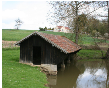
Un lavoir à Bazoches-sur-le-Betz. Dans ce cas bien spécifique du fait de la proximité de l'eau, le soubassement en pierre revêt une grande importance.
