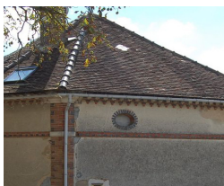
Des briques encadrant un œil de bœuf - Les Régipaux - Egriselles le Bocage
