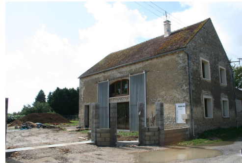
Restauration hasardeuse d'une ancienne grange avec remplacement de l'ancien portail par des volets métalliques et des baies vitrées. Le pignon a quant à lui été percé de quatre fenêtres carrées, contre-modèle des huisseries utilisées dans le Bocage, plus hautes que larges
