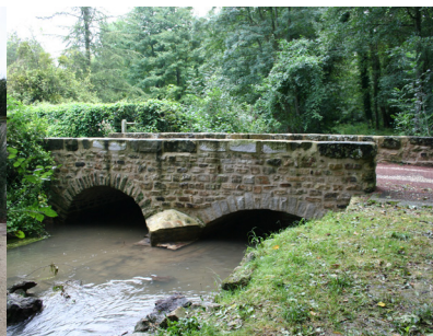
Pont sur l'Orvanne à Villecerf à deux arches en plein cintre. Ce pont a obtenu le prix Jean Coret, décerné par l'AHVOL, suite à sa restauration en 2013
