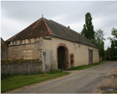
Grange à Cheroy (Maurepas). A noter le toit à quatre pentes, rare pour un bâtiment d'exploitation et son portail à arc en plein cintre.
