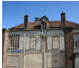
Mairie rurale de Saint-Ange-le-Viel. Petit édifice R+0 à perron. La recherche de la symétrie est toujours là mais seule la haute lucarne avec l'horloge représente le vocabulaire architectural municipal
