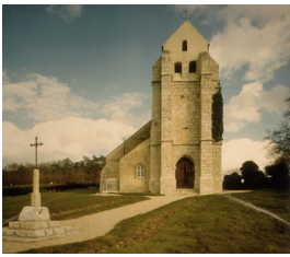
Ancien cimetière de Chevannes aujourd'hui transféré en arrière de l'église. La place libérée forme ainsi le parvis autour de l'église
