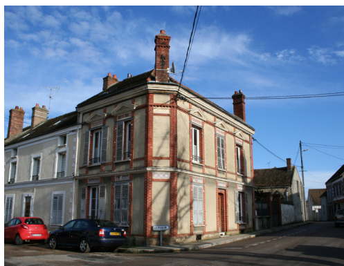
A Vouix, maison de bourg d'angle avec sa corniche et ses frontons triangulaires surmontant les fenêtres
