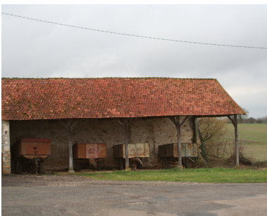
Hangar permettant l'abri de remorques à Noisy-Rudignon.
