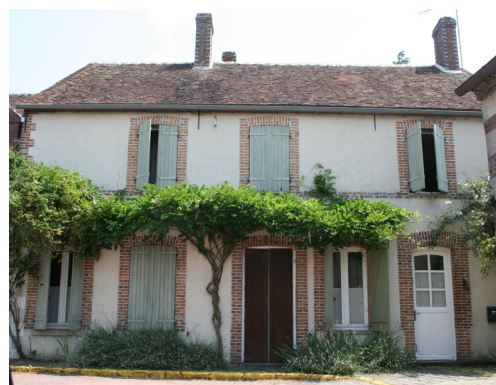
Fenêtres à arcs surbaissés et entourage en briques au Bignon-Mirabeau
