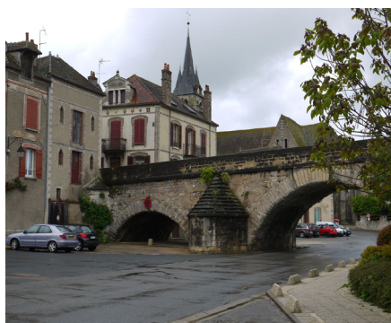
Vieux pont à Pont-sur-Yonne
