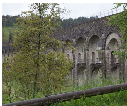
Aqueduc de la Vanne à Villeperrot
