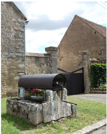
Puits, à treuil
