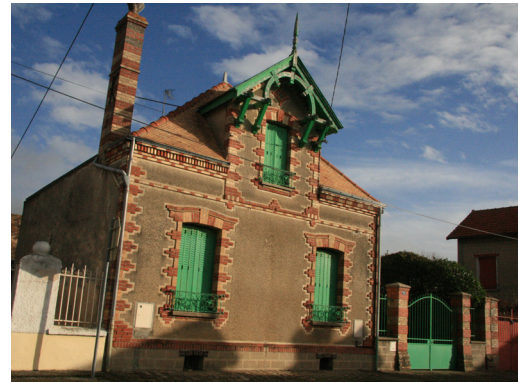
Constructions le long de la N6, Champigny
