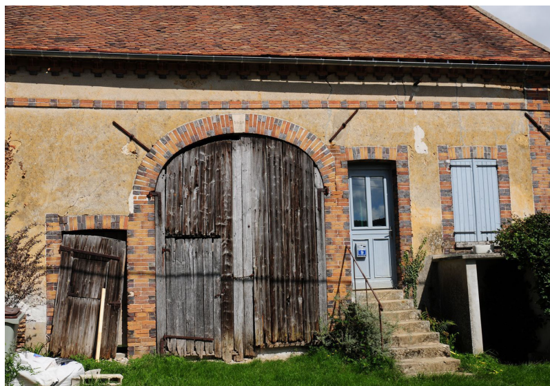
Façade de maison, les Régipaux, Égriselles-le-Bocage
