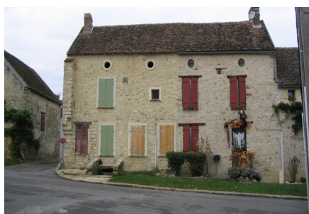
Maison et cave semi-enterrée, Flagy
