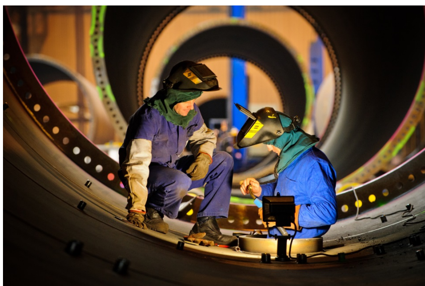
Poste de soudage et soudeur semi-automatique dans un mât d'éolienne en cours d'assemblage © Arnaud Bouissou/MEDDE-MLETR
