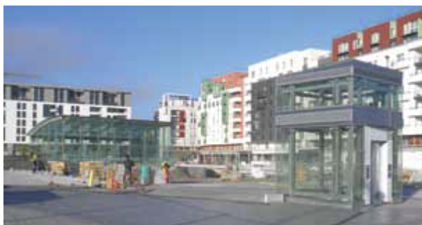
Figura 27. A nova estação de metrô da linha 12 no coração da Plaine Saint-Denis
