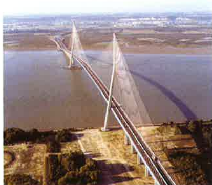
Le pont de Normandie du Havre.
