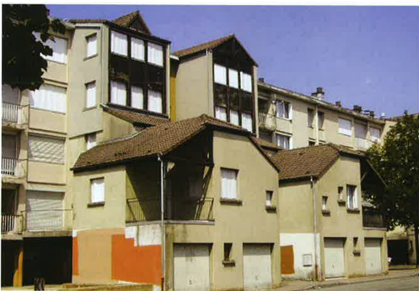
Des ensembles de grands logements promis à la démolition : la barre Bruxelles dans le quartier des Résidences. © D.R.
