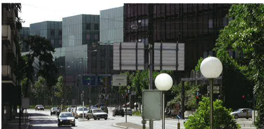
Chantier en cours du centre d'affaires du quartier de la gare de Bâle – «Jacob Burckardt Haus» –, partie du projet «Euroville».
