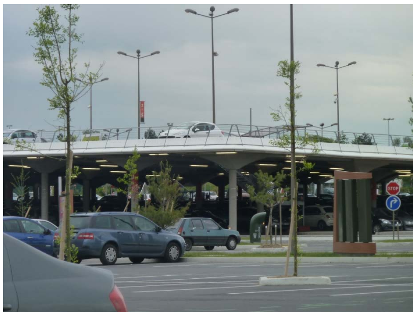
Centre commercial à Claye-Souilly : un effort de densification avec des parkings sur 2 niveaux
