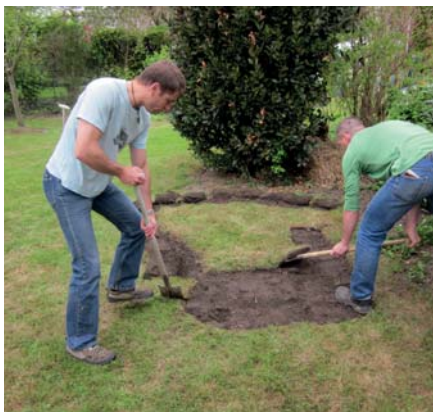
Décapage de la pelouse avant l'installation de la mare.
