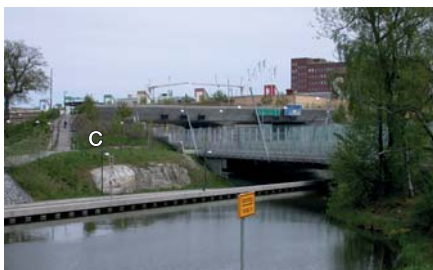
La renaturation C des berges du canal en contrebas du périphérique.
