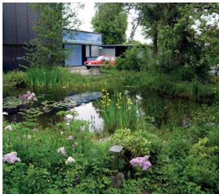
Mare recueillant les eaux de pluie autour de la station d'épuration et de traitement des eaux.
