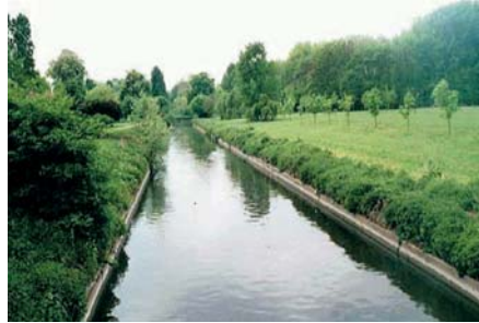
Les berges bétonnées bloquaient initialement la dynamique naturelle de l'Orge.
