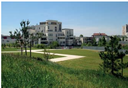
Vue de l'extension depuis une butte arborée.
