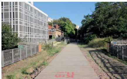
La petite ceinture sur un tronçon réaménagé dans le XV e arrondissement.
