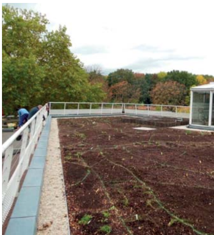
Mise en place du substrat (octobre 2012).
