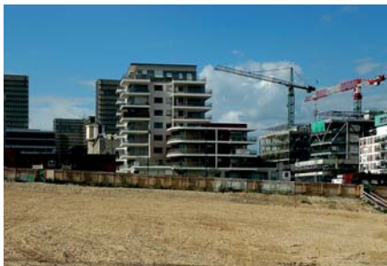
Le site, à forte pente, avant les travaux en 2006.
