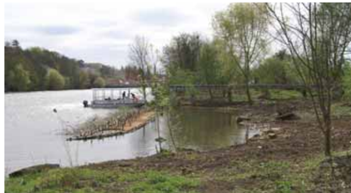
Renaturation des berges à Neuville-sur-Oise (95) par le SMBO
