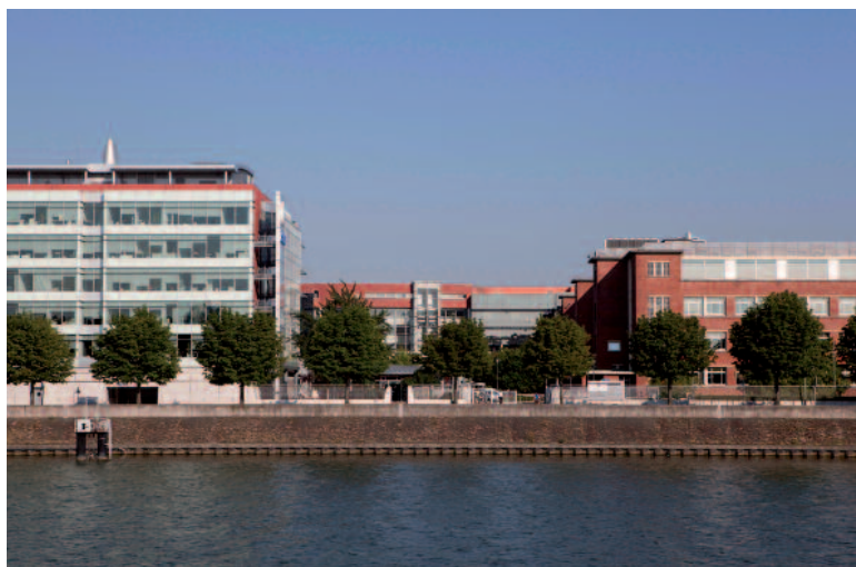
Proximité de Paris, accessibilité, qualité de l'environnement constituent des facteurs d'ancrage.
