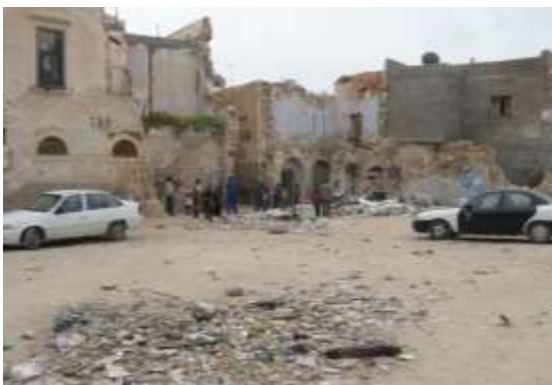
Maisons démolies du quartier juif de la Médina de Tripoli.
