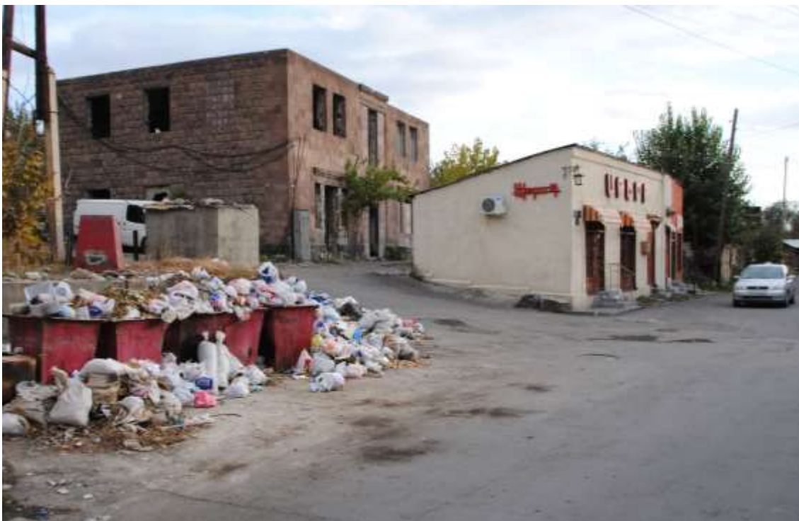
La rue Rustaveli avec l'un des deux seuls commerces du quartier Kond. Ce secteur pourrait accueillir une petite centralité. P. Lecoart IAU idF
