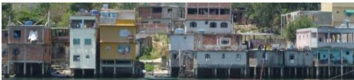
Habitations illégales dans le quartier de l'île de Caieiras à Vitoria. P. Lecroart IAU idF
