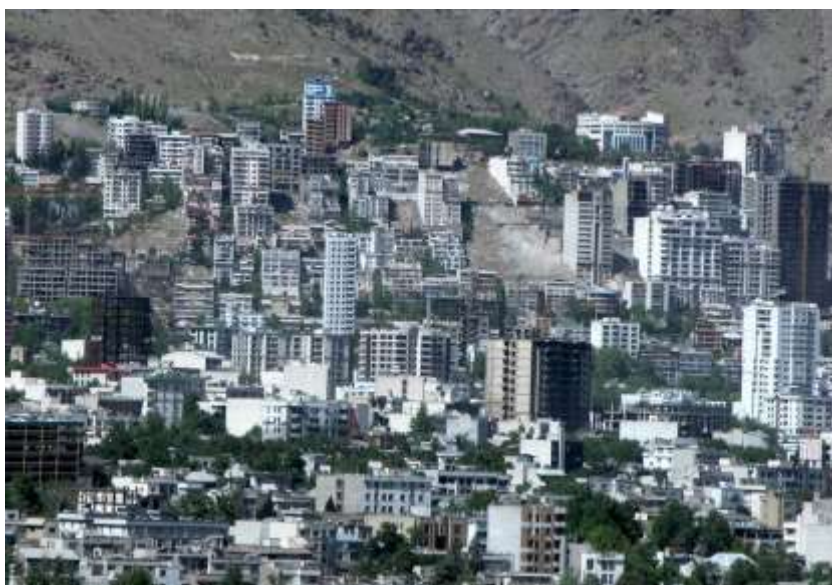
Construction anarchique de tours résidentielles sur les pentes de l'Alborz en 2005.
