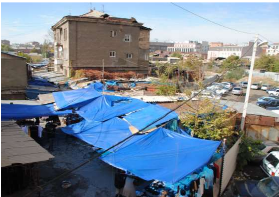
Un cœur d'îlot ancien dégradé en centre-ville destiné à disparaître dans le cadre du Plan Tamanian. P. Lecoart IAU idF
