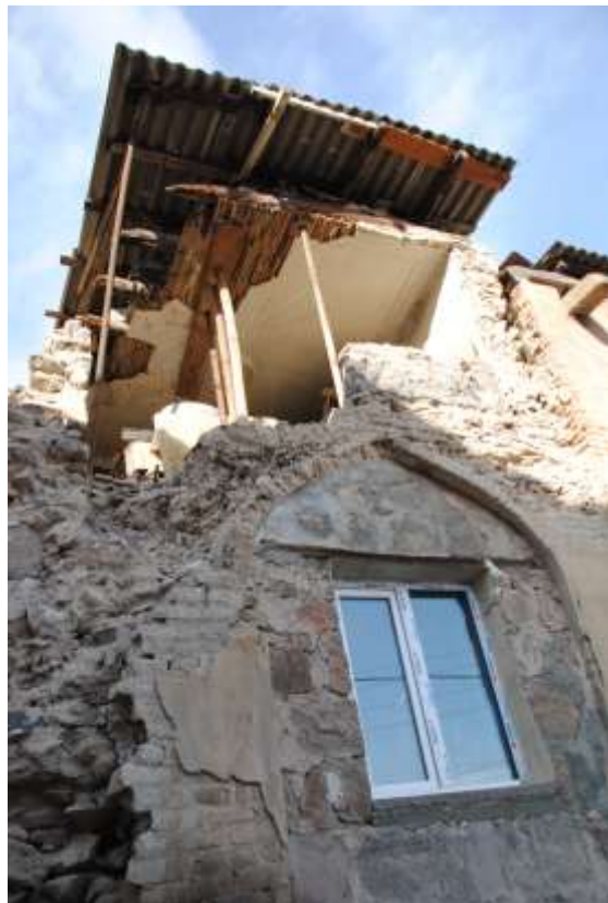
Une ancienne mosquée persane du XVIIe très dégradée. P. Lecroart IAU îdF
