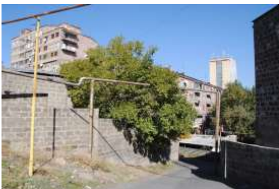
Les canalisations de gaz sont aériennes. P. Lecroart IAU îdF
