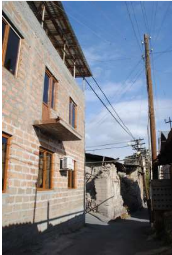
De nouvelles constructions non réglementaires à Kond. P. Lecroart IAU îdF
