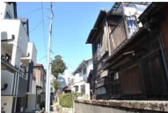
Insertion soignée des nouvelles constructions (à gauche) dans le tissu urbain existant : les gabarits et les hauteurs du bâti sont strictement régulés.
