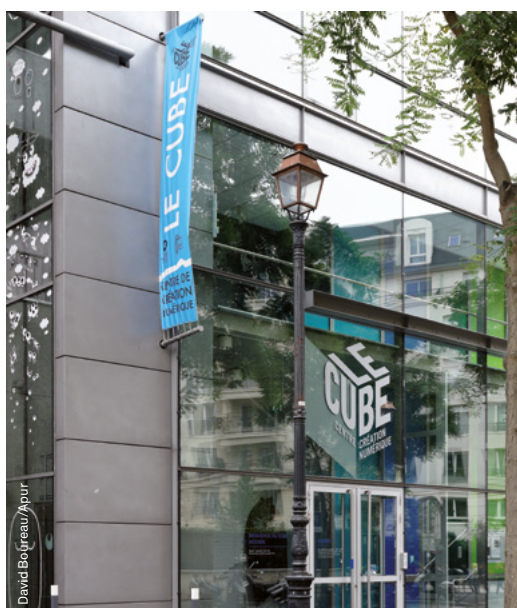
Le Cube (Issy-les-Moulineaux, 92), centre de création numérique.
