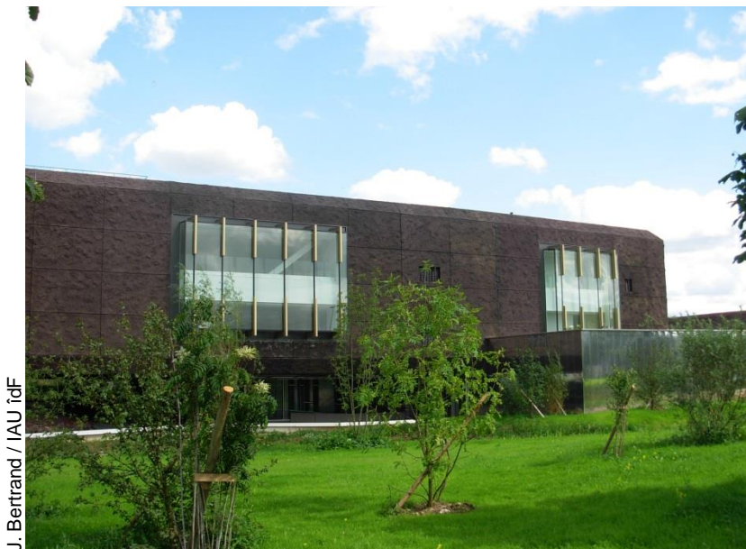
Bâtiment de la bibliothèque universitaire
