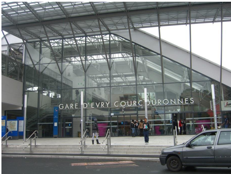
Entrée principale de la gare d'Évry Courcouronnes
