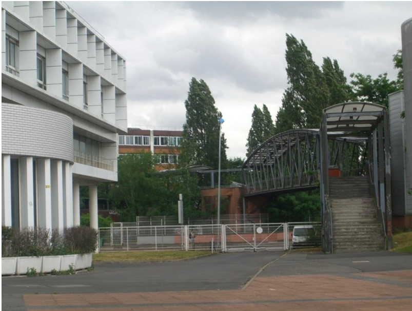
Passerelle enjambant la D29
