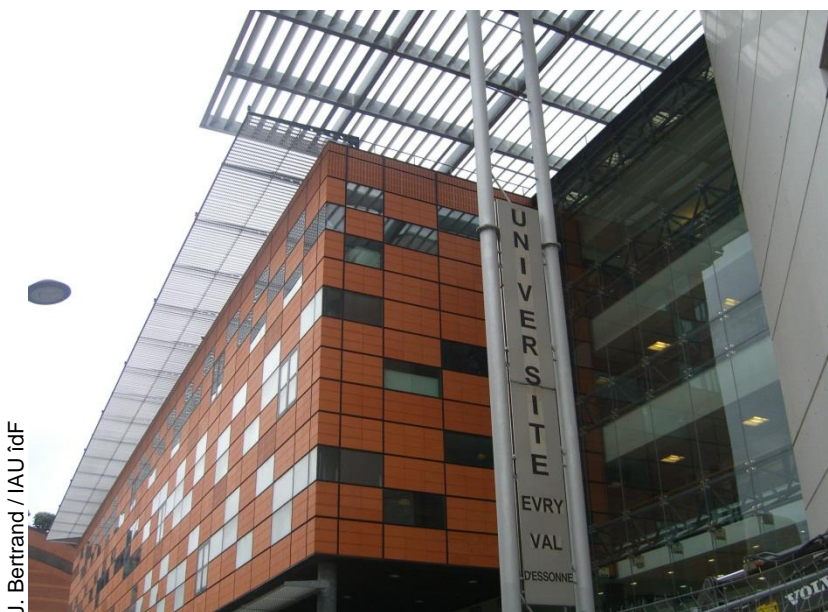
Bâtiment Maupertuis de l'UEVE
