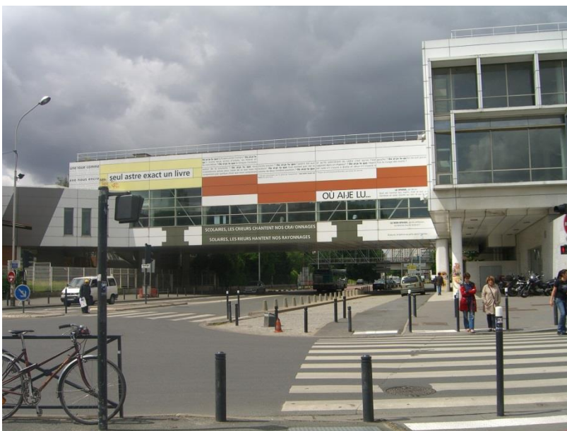
Bâtiment pont au-dessus de la D29
