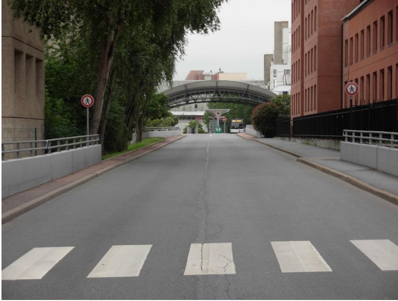
Voie uniquement réservée au bus desservant la gare routière haute
