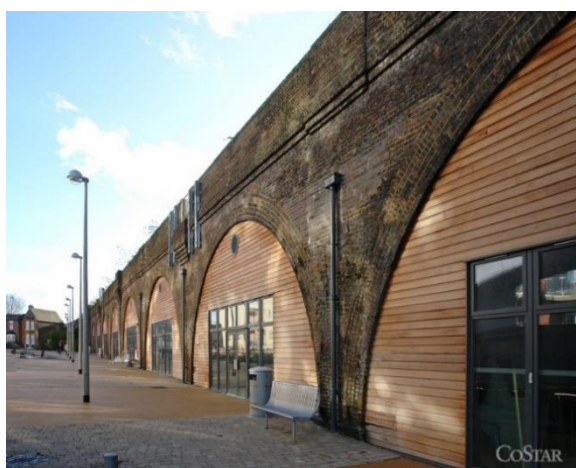
Londres - South Harrow Viaduct
