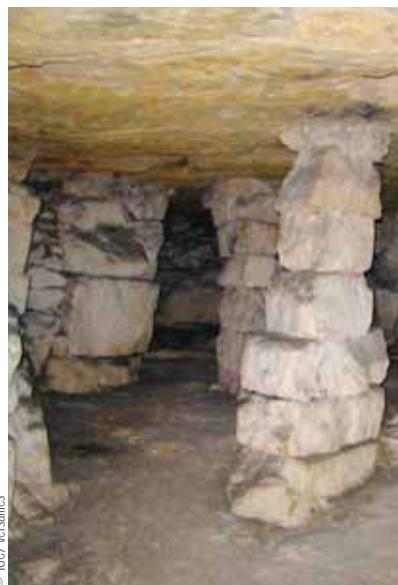
Lorsque la présence de vides souterrains est clairement localisée, des interventions sont réalisées sur la cavité elle-même, par comblement ou consolidation.
