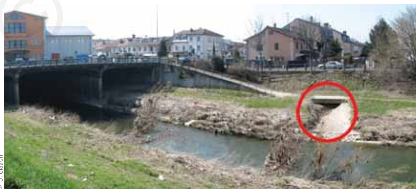
Mulhouse : derrière la place du marché, le canal enterré refait surface. Les berges sont marquées par les variations du niveau de l'eau. On aperçoit une buse (entourée en rouge).
