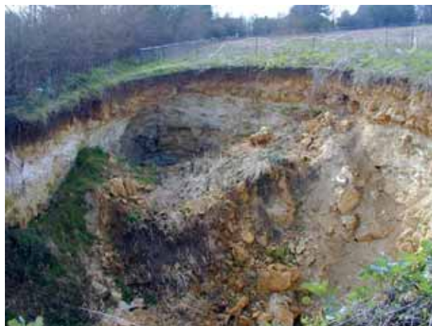
En grande couronne, les anciennes carrières sont partiellement localisées. La prise en compte de ce risque est donc difficile dans l'aménagement car son ampleur reste mal estimée...
