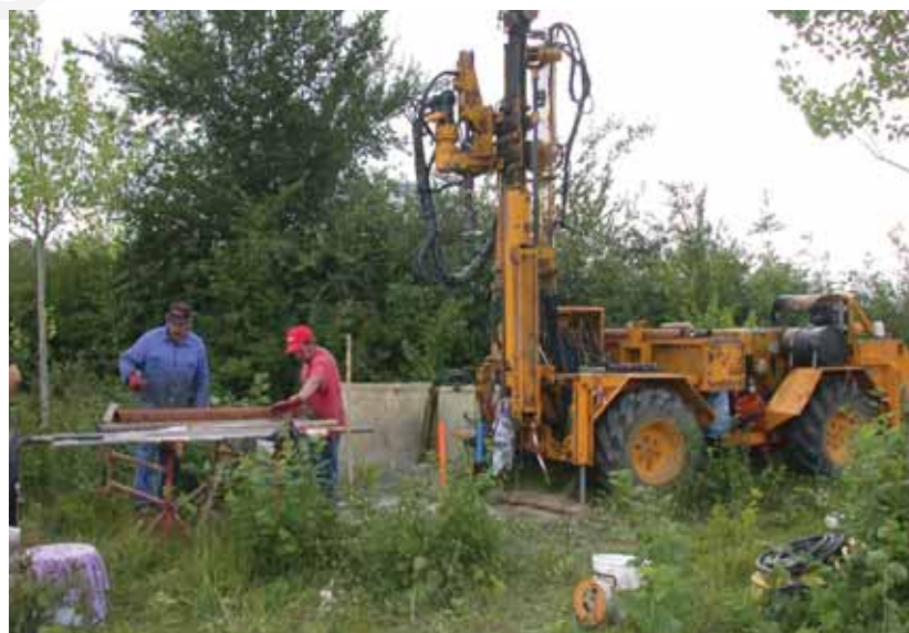
Un sondage de reconnaissance.
