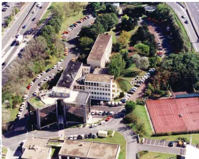
Les bâtiments de la Direction de l'eau et de l'assainissement, équipés de toitures terrasses, d'espaces paysagers inondables, participent à la sensibilisation aux techniques alternatives.
