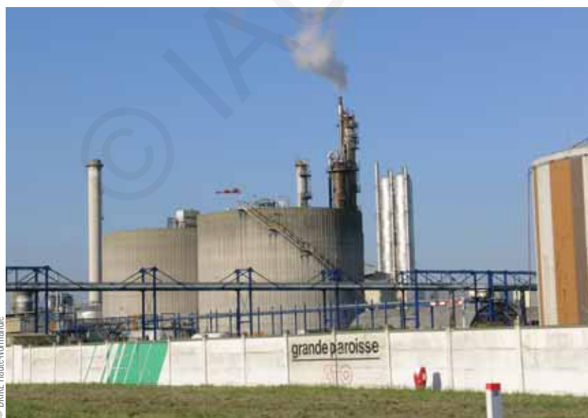
Stockages de la société Grande Paroisse au Grand-Quevilly.
