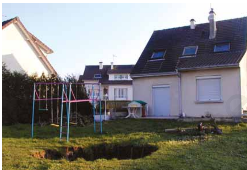
Les fontis sont des effondrements, le plus souvent circulaires, localisés à l'aplomb des cavités souterraines pré-existantes. Les vides peuvent remonter vers la surface après affaissement des terrains qui les recouvrent et provoquer alors une cavité appelée «fontis».
