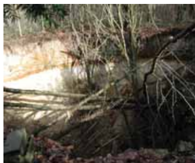
L'exploitation intensive du gypse pendant plus d'un siècle sur le massif de l'Hautil rend toute opération d'aménagement impossible en raison de l'instabilité des galeries souterraines.
