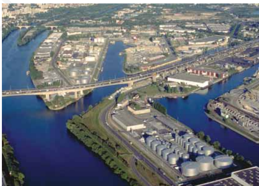
La problématique de risques d'un dépôt d'hydrocarbure en zone dense se pose en termes d'enjeux très locaux. Sa délocalisation éventuelle a des conséquences dépassant le seul site et des impératifs de protection des populations.
