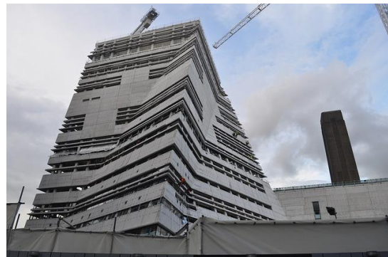
Chantier d'extension de la Tate modern à Londres, ouverture du nouveau bâtiment prévue courant 2016.
