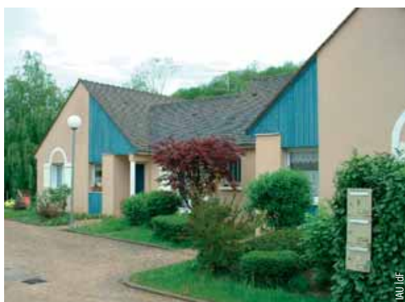
Logements locatifs sociaux, vue depuis l'entrée de la parcelle
