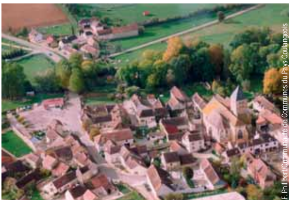
La zone de loisirs et le site de la station entre le centre-bourg et son hameau
