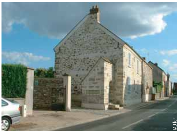
Vue de l'opération depuis la rue de la Croix
