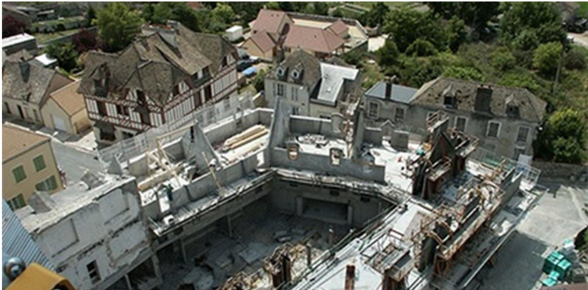
Figure 13 - Le chantier de la Boldoflorine, Houdan (78)
