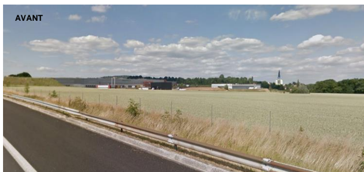
Vue de l'existant
