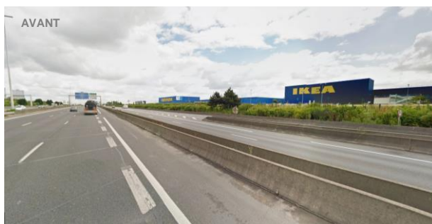
Vue de l'existant
