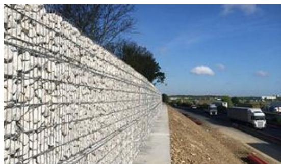
Mur antibruit en gabions au sommet de la butte existante
