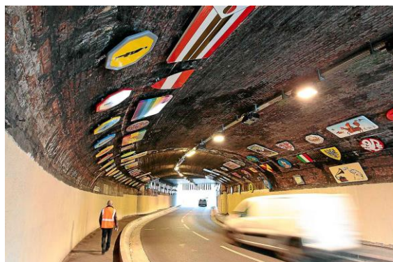
Photo actuelle du tunnel
