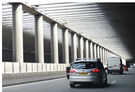
Tunnel qui suit le mur anti-bruit du Bourget
