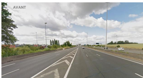
Vue de l'existant
