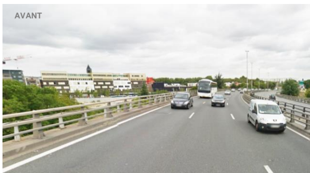
Vue de l'existant
