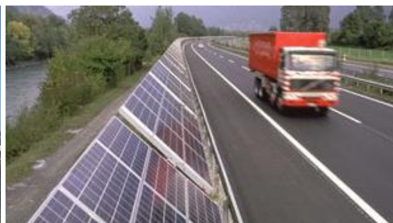
Murs antibruits couverts de panneaux solaires
