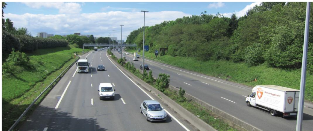
Des espaces à investir des abords aux terre-pleins, Crédits image : IAU
