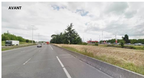
Vue de l'existant
