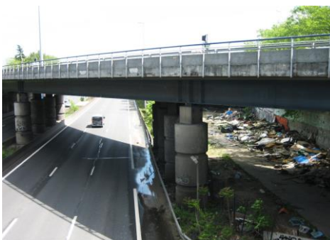
Franchissement après le Fort de l'Est à St-Denis
