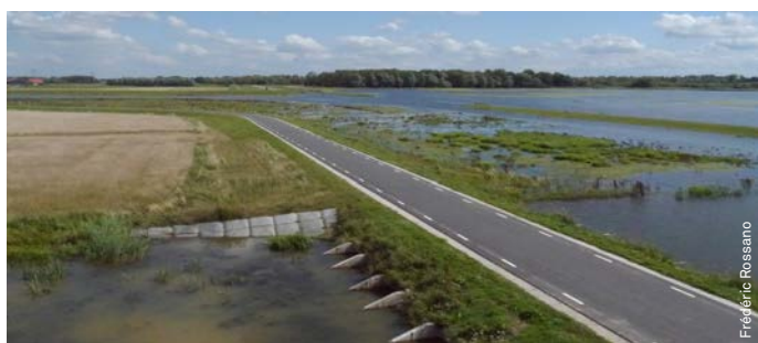
La route submersible traverse le couloir d'évacuation des crues. L'ouverture de la digue laisse l'eau s'étendre dans les zones naturelles ou agricoles.
