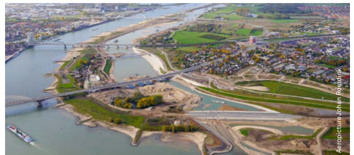
Nijmegen « après » : le projet RVR « de l'espace pour la rivière » a intégré la démolition, le recul et la reconstruction de la digue, le creusement du nouveau bras de rivière et sa presqu'île, la construction de ponts, de passerelles et d'un barrage. L'ensemble compose un nouveau paysage fluvial.
