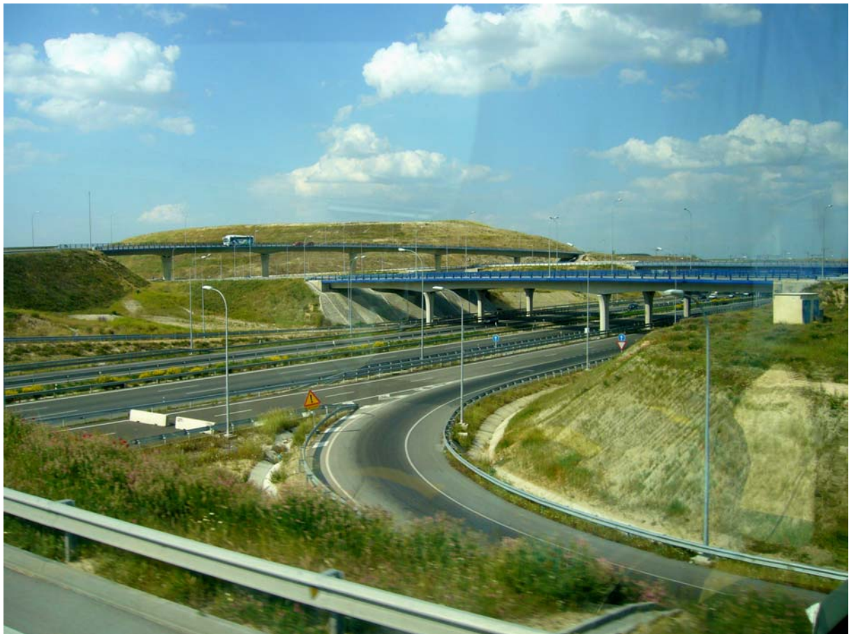
La M-50 : le réseau autoroutier, très extensif, consomme beaucoup d'espace et cloisonne les quartiers © P.Lecroart-IAURIF-2006
