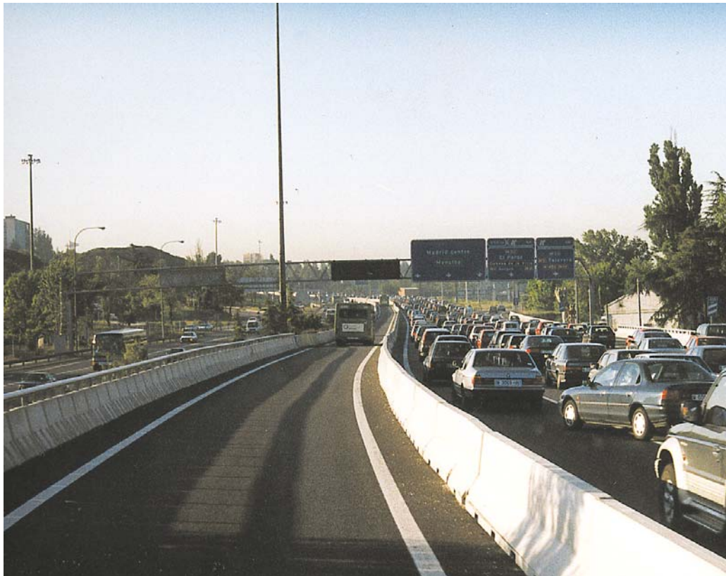
Site propre du BUS-HOV inséré au centre de l'autoroute A6. © Comunidad de Madrid
