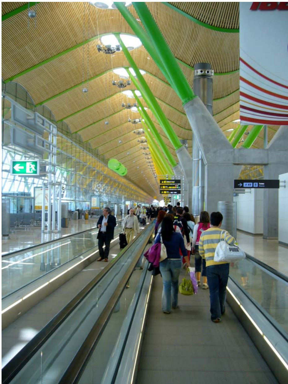
Le nouveau terminal T4 de l'aéroport de Madrid (2006). © P.Lecroart-IAURIF-2006
