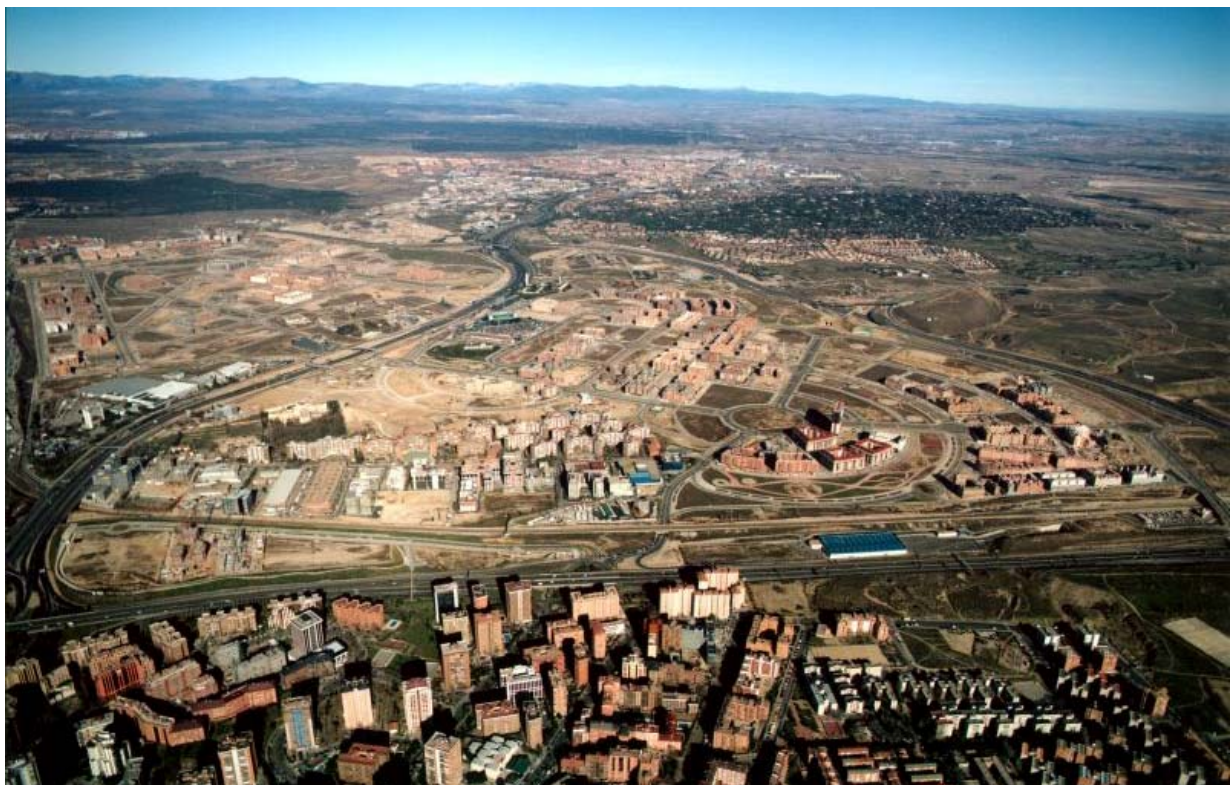
Le quartier Sanchinarro en cours d'aménagement (vers 2003) : une urbanisation nouvelle de 13 500 logements au nord de Madrid en partie sur un ancien dépôt de gaz. Le quartier est ceinturé par 3 autoroutes : M-30/M-11 au 1 er plan, M-40 à l'est, A-1 à l'ouest. ©City of Madrid-2003.
