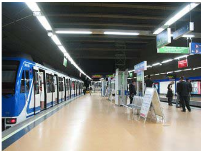
Station Puerta de Arganda sur l'extension de la ligne 9
