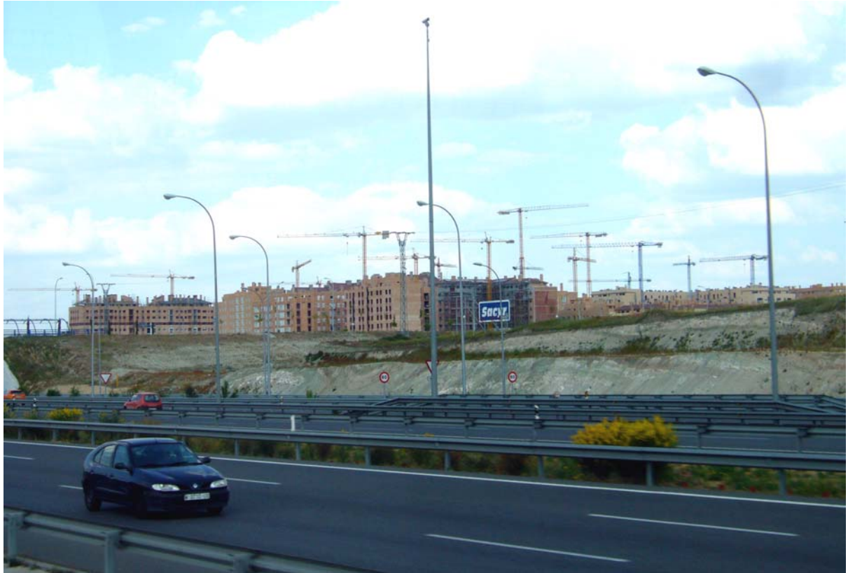
A gauche, la construction du nouveau quartier Vallecas en 2006. © P.Lecroart-IAURIF-2006
