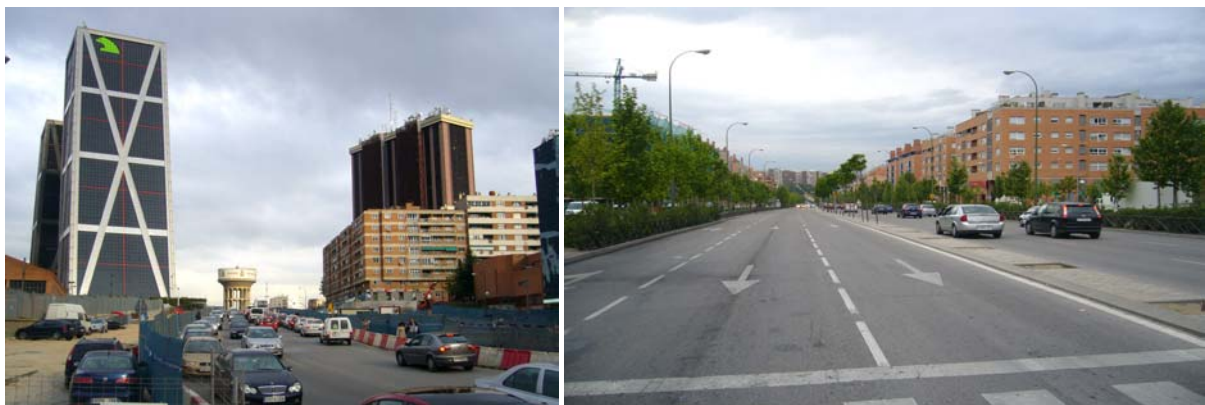
A gauche, la percée de l'Avenida Asturias en travaux (au fond les fameuses tours Kio construites en 1996 sur la Place de Castille). A droite, l'avenue Asturias achevée : une large avenue, deux contre-allées et des immeubles d'habitation à R+6. © P.Lecroart-IAURIF-2006
