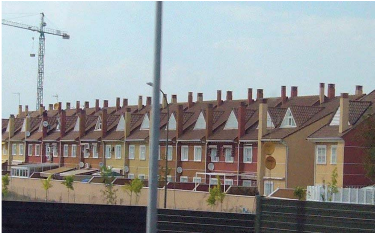
Maisons en bandes le long de l'autoroute A2. Le marché de l'habitat individuel est en pleine croissance © P.Lecroart-IAURIF-2006
