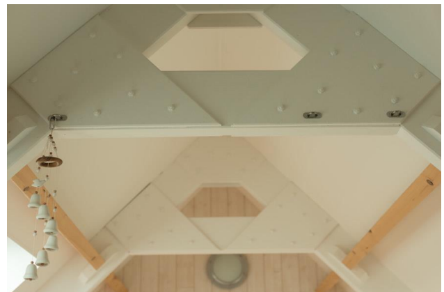
Plusieurs éléments d'origine ont été conservés comme ces solives repeintes en blanc.
