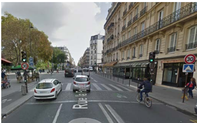
Un exemple d'aménagement récent : Rue Lafayette, voie structurante parisienne avec 2 files en sens unique et couloir bus, réduite à 30km/h au droit du square Montholon, intégrant une bande cyclable à contre sens
