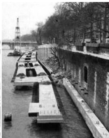
Source : Etude d'impact 2016 Viaduc ossature préfabriquée : quai de Gesvres et quai de la Mégisserie
