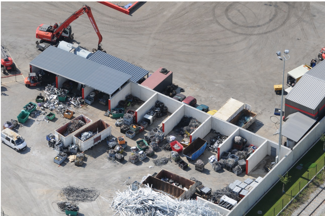
Certaines activités (recyclage et traitement des déchets) constituent un enjeu en termes de dommages potentiels sur l'environnement (pollutions). Crédit photo : Didier Comellec
