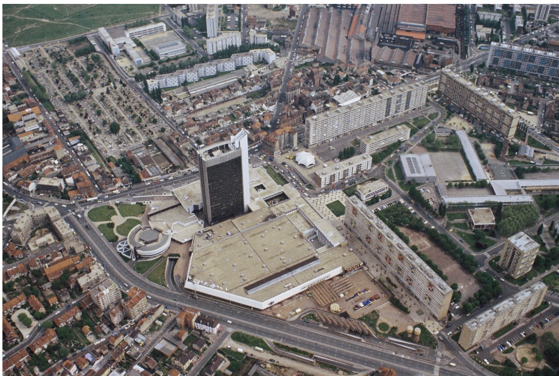
Les services publics et leur continuité d'activité (ici la mairie de Gennevilliers) constituent le premier maillon de la résilience des territoires.
