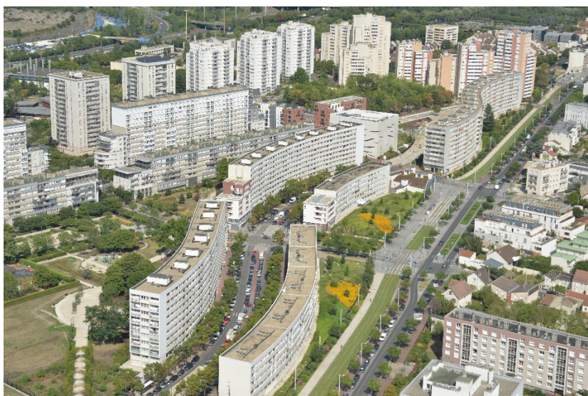
Le quartier des « Courtilles », classé en « quartier prioritaire de la politique de la ville », est fortement exposé aux inondations.
