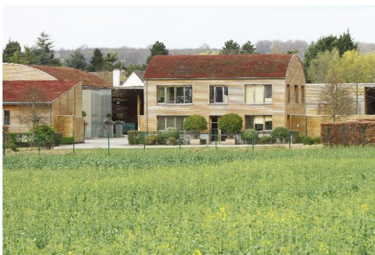
Entreprise à Saint-Nom-la-Bretèche (CC Gally Mauldre)©
