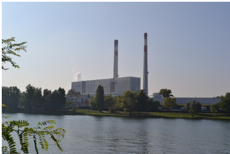
Centrale électrique des Ardoines – Vitry-sur-Seine © Laure de Biasi – IAU îdf.
